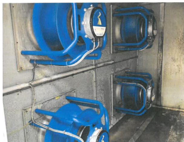
Ugradnja EC ventilatora
